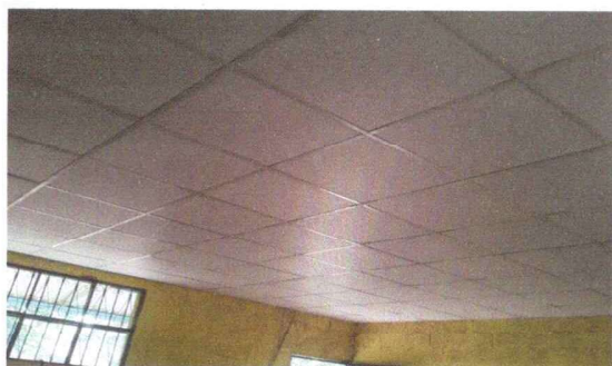
Foto1: Finalización de Instalación de Cielo Falso.
