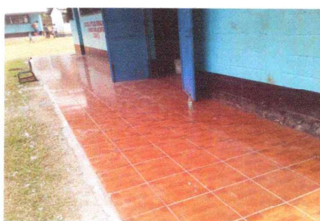
Foto 2: Finalizacion de Colocacion de Piso Ceramico en Corredor.
