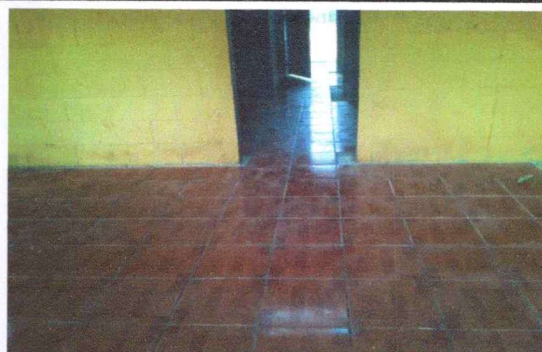
Foto 4: Finalizacion de Colocación de Piso Ceramico dentro del Aula.
