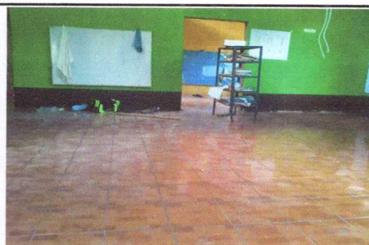
Foto 6: Finalizacion de Instalacion de Piso Ceramico.
